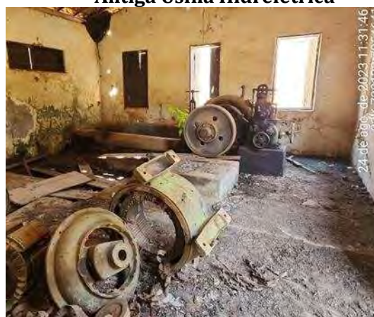
Figura 83 Estrutura do Conjunto da Antiga Usina Hidrelétrica
