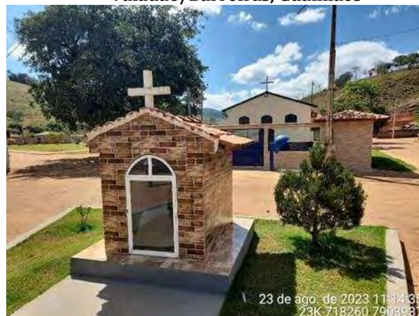
Figura 64 Igreja na Comunidade Valadão/Barreiras, Guanhões
