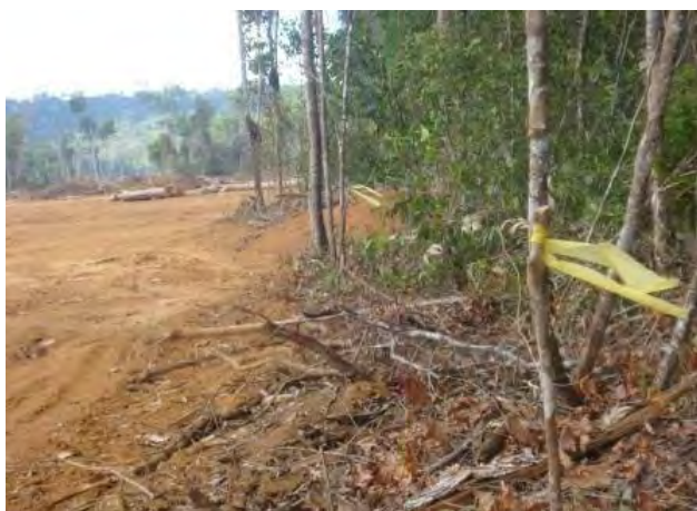
Figura 15.2.1: Exemplo de demarcação feita por topógrafos da área autorizada para ser suprimida (NEVES, 2007).
