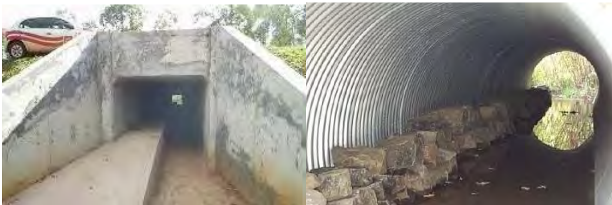
Figura 15.2.13: Exemplos de possíveis modelos passagem inferior de fauna (bueiros modificados, para passagens de animais de pequeno, médio e grande portes e túneis para passagens de répteis e anfíbios).
