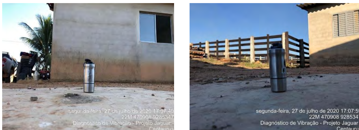
Figura 10.1.32 - Detalhe do posicionamento em campo dos equipamentos no ponto P4.
