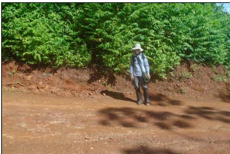
Figura 10.1.52 - Saprólito de subvulcânica ácida em corte de acesso.
