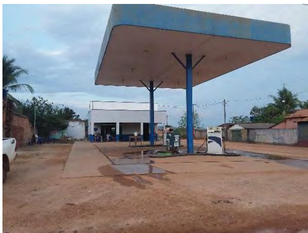
Figura 10.3.68: Posto de combustível que atende ao distrito de Ladeira Vermelha e vista ao fundo de uma lanchonete.
