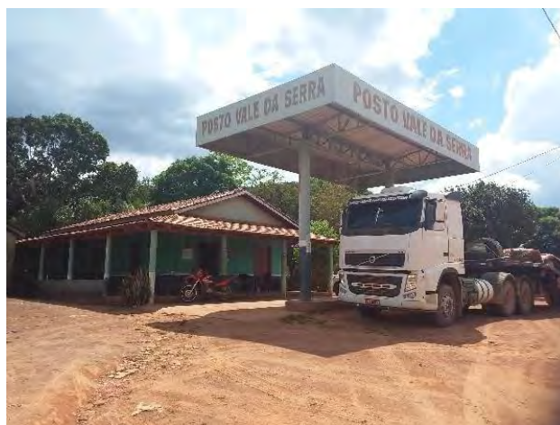
Figura 10.3.69: Posto de combustível que atende à vila Minasul.
