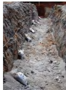
Trincheira aberta no Projeto Jambreiro
