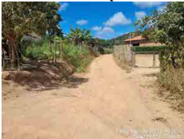
Figura 145 Via dotada rede de energia elétrica em Quilombo
