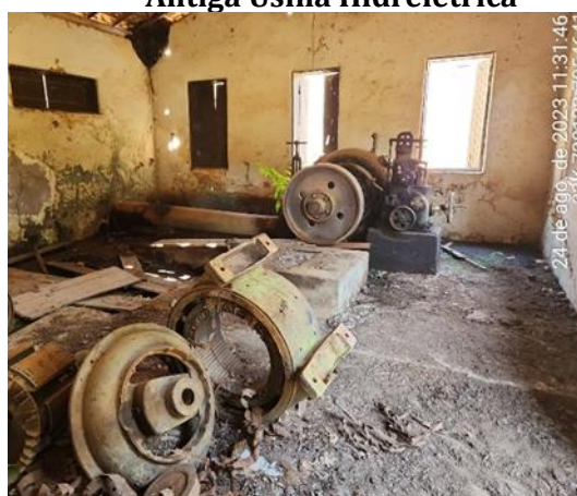
Figura 84 Estrutura do Conjunto da Antiga Usina Hidrelétrica
