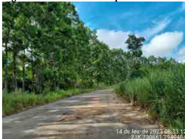
Figura 161 Via de acesso para AEL: MG-117
